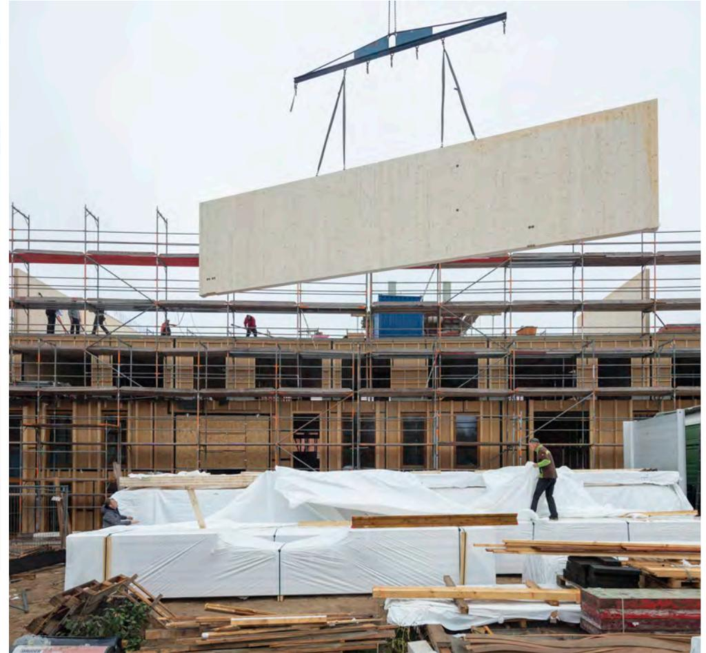
*Massivholzkonstruktion – das im Gebäude verbaute Holz bindet 1.500 Tonnen CO<sub>2</sub> (1t/m<sup>3</sup> Holz)*
