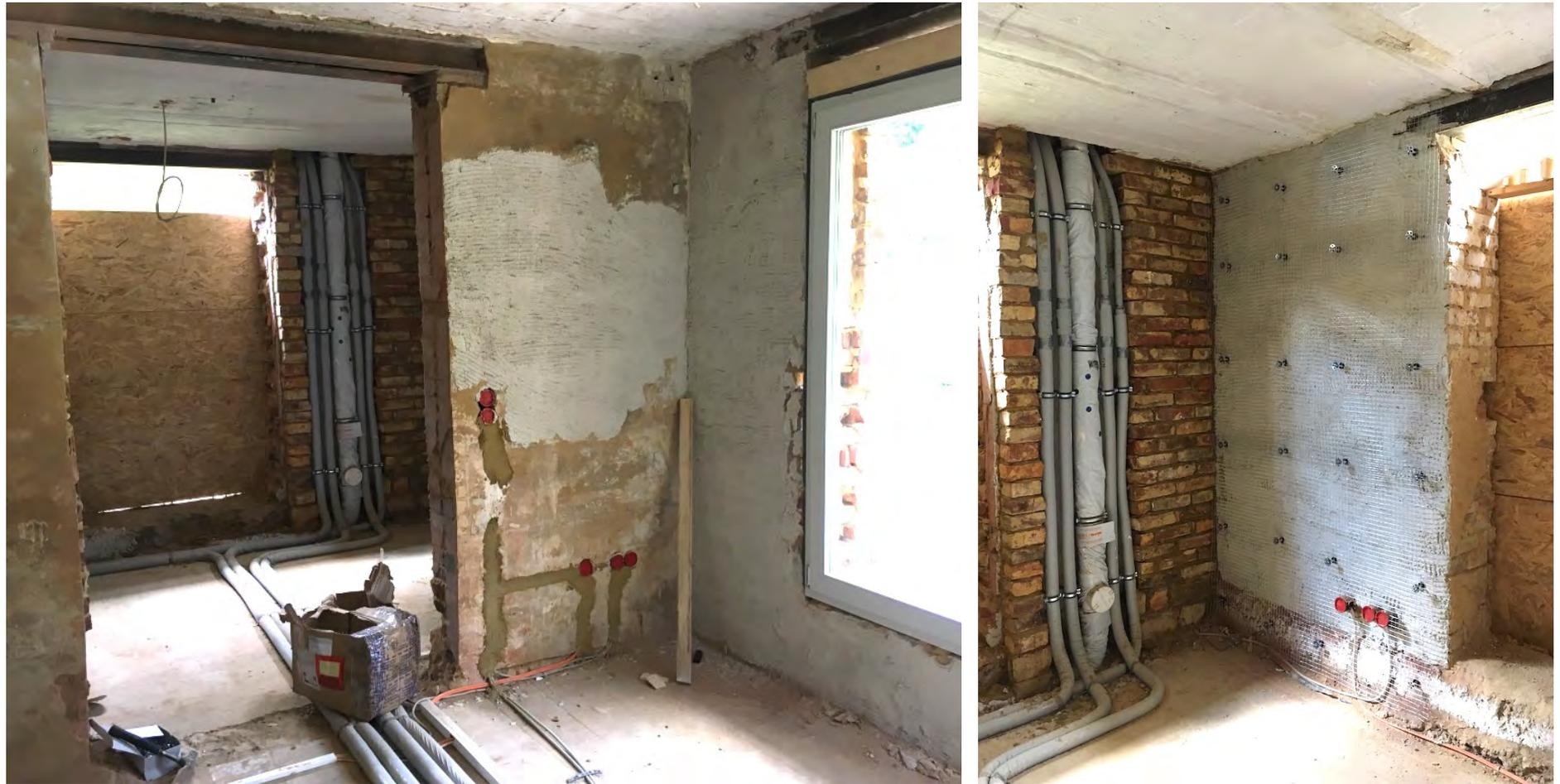
*Sanierung Erdgeschoss – ehemalige Waschküche und Öltankraum – Kalkdämmputz Innen*
