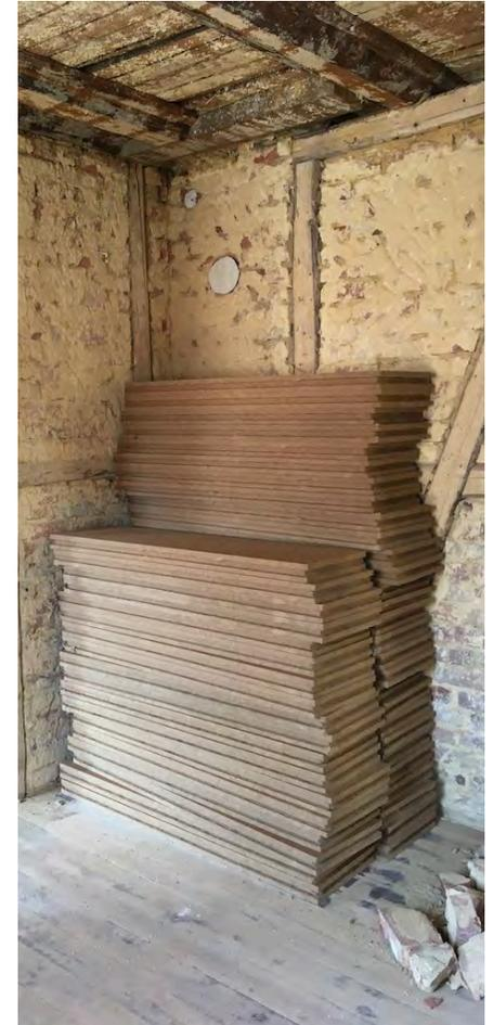
*Rückbau auf ursprüngliche, langlebige Rohbaustruktur aus Holz-Ziegel-Lehm*
