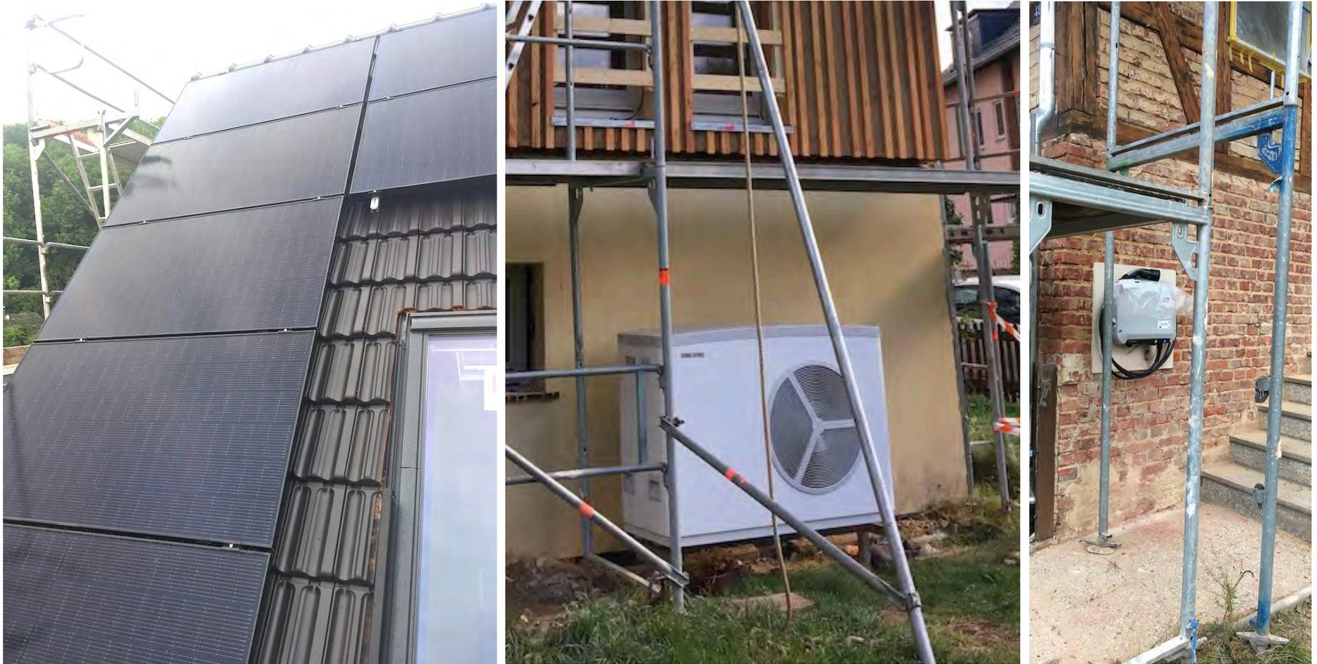
*Photovoltaik - Heizanlage mit Wärmepumpe – Ladestation für vollelektrischen PKW –
