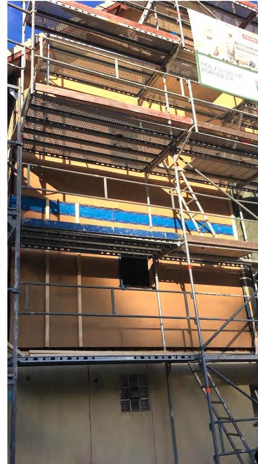
Fassadenarbeiten – Aufarbeitung Sichtfachwerk und Außendämmung mit Holzfaser an Westfassade
