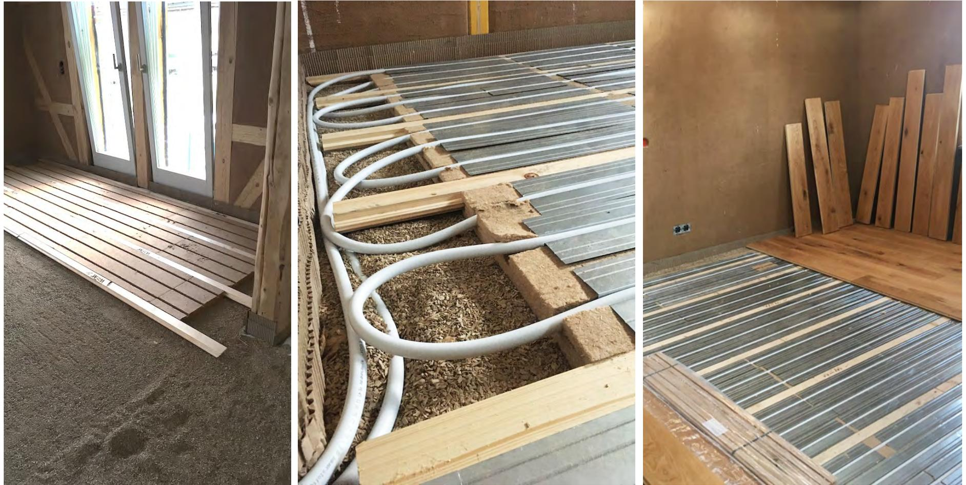
*Bodenaufbau mit Fußbodenheizung – Holzweichfaserplatten auf trockener Holzgranulatschüttung*
